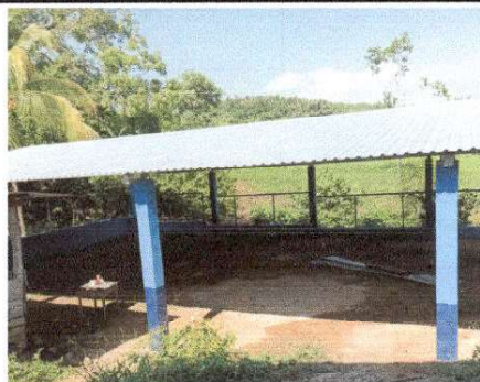
Foto 1: Sustrucción de lamina por lamina (troquelada) aluzinc calibre 26
