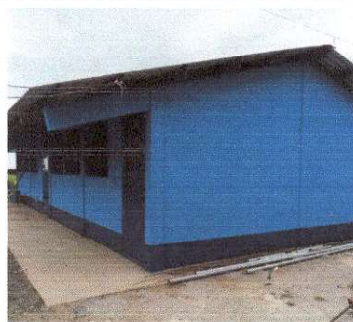
Foto 4: Pintura en muros exteriores e interiores
